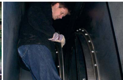
Inspektion von Klappen einer RTO-Anlage
