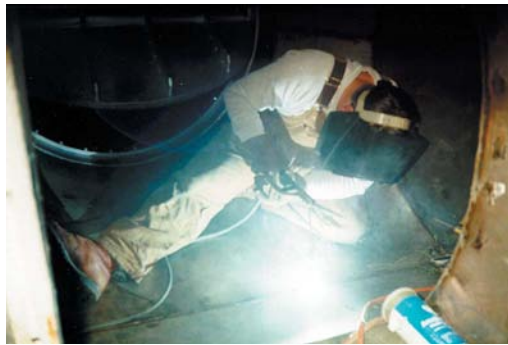
Schweißen von Kanalsystemen
