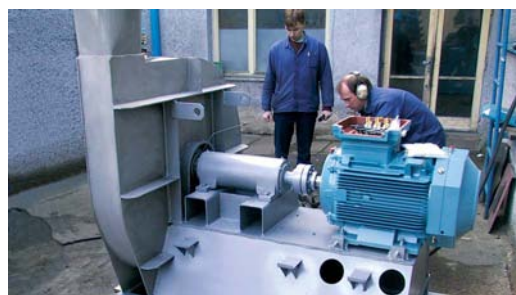
Vorbereitungsarbeiten zum Ventilator-testlauf
