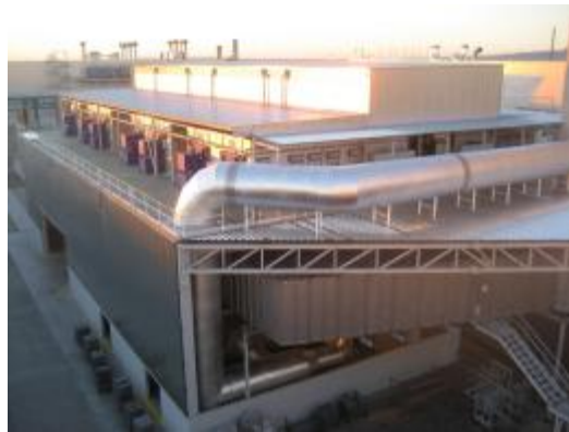
Eine Aufkonzentrierungsanlage mit 14 identisch gestalteten Ecopure ® KPR-Konzentratormodulen reinigt die Luft bei GM Opel in Zaragoza.
