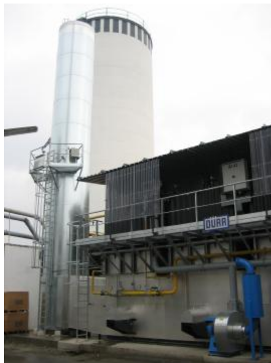
Ecopure® RTO-Anlage bei Interlübke in Rheda-Wiedenbrück
