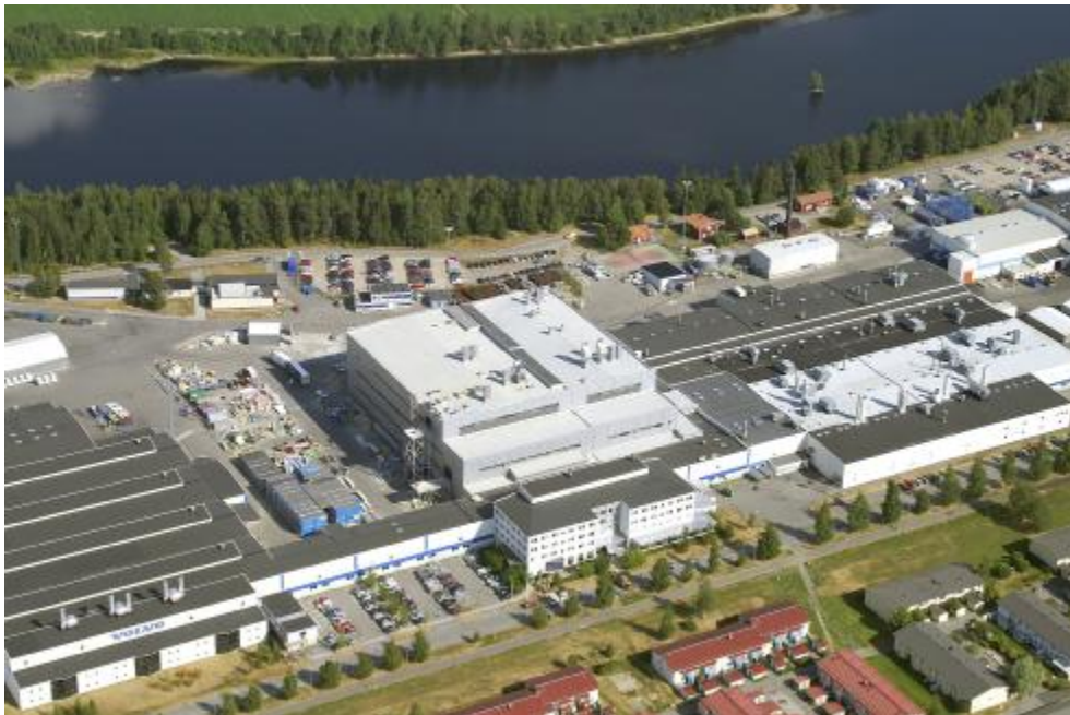
Die neue Decklacklinie bei Volvo Trucks in Umeå, Schweden, ist eine hoch entwickelte und vollautomatische Anlage.
