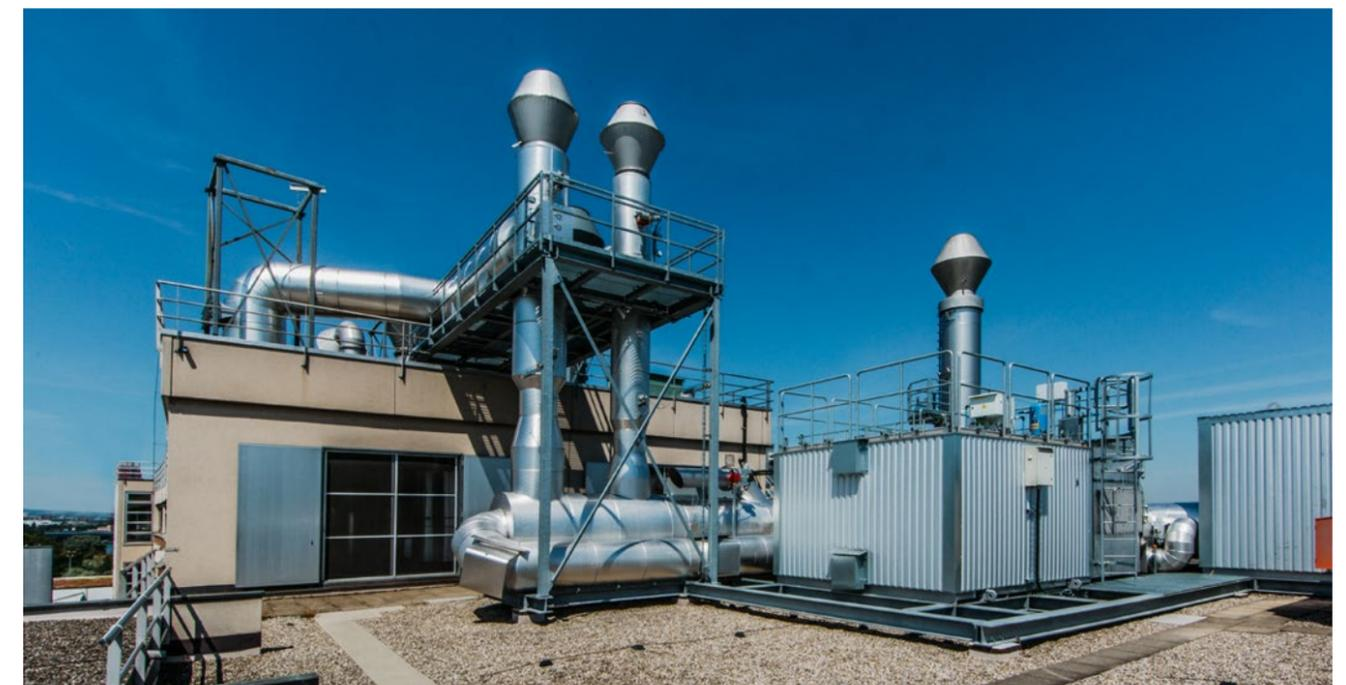
Elektrische Abluftreinigung mit 99,7 % Abreinigungsgrad.
